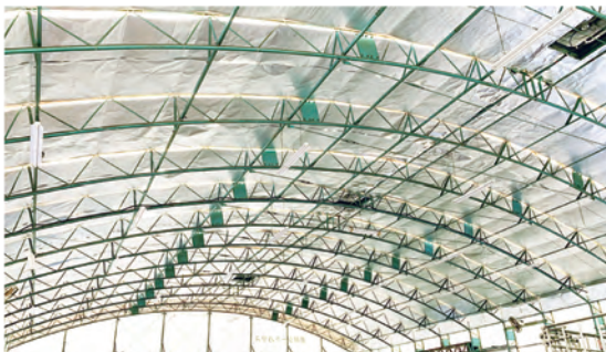
テント倉庫内
